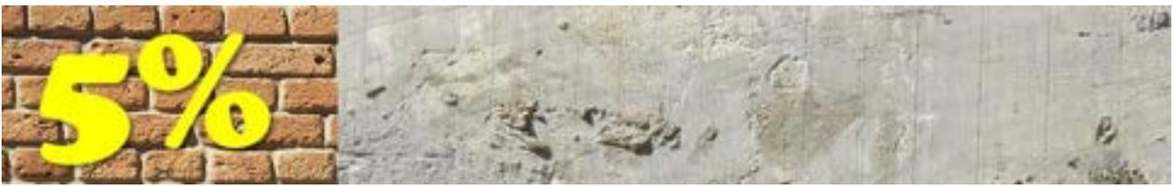
deteriorada (fragmentos de azulejo ausentes, infiltrações, reboco aparente, desbotamento da camada pictórica).
