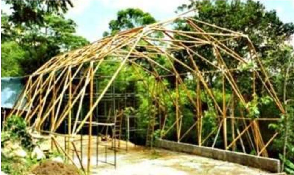
Figura 6 – Cobertura com estrutura em bambu tratado baseada em Origami. Santana do Parnaíba. 2000.
