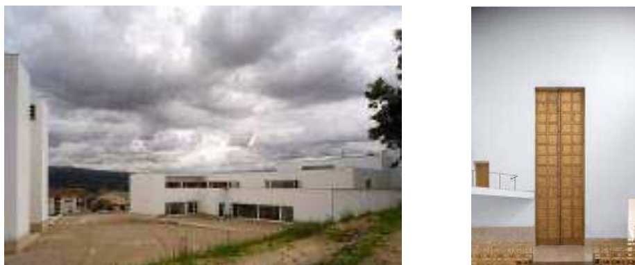
Figura 9. Vistas laterais e frontais da igreja e centro paroquial e vista interna da entrada da igreja. Fonte: Fernando Guerra /Casa da Arquitectura.
