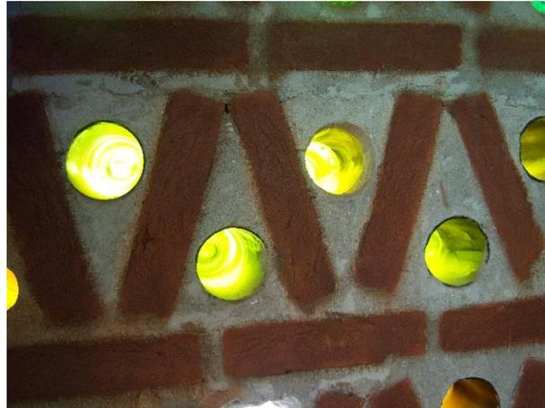
Figura 10 Aparelho Lotufo de tijolos com incrustações de garrafas coloridas. Foto da autora
