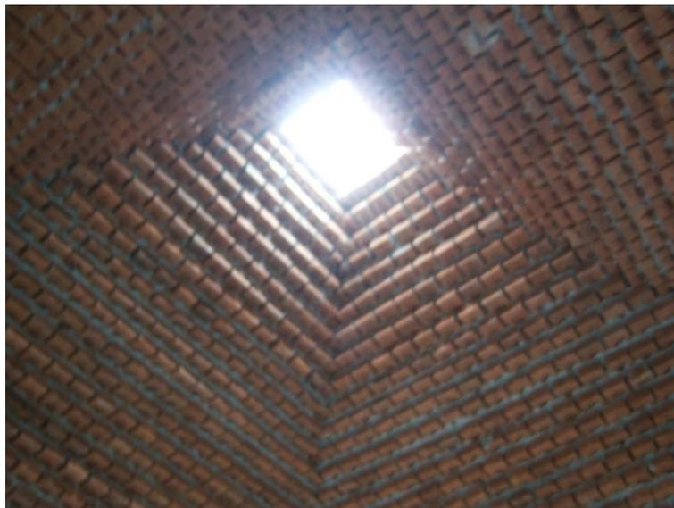
Figura 3 Cobertura de ferro-tijol, em forma de tronco de pirâmide denteada. Foto da autora.
