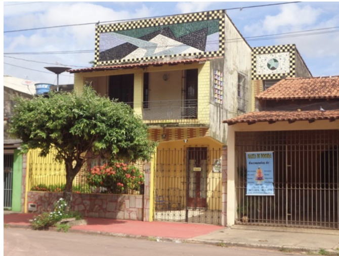
Figura 4 - Fachada da casa nº 257. Fonte: MODESTO et al., 2013
