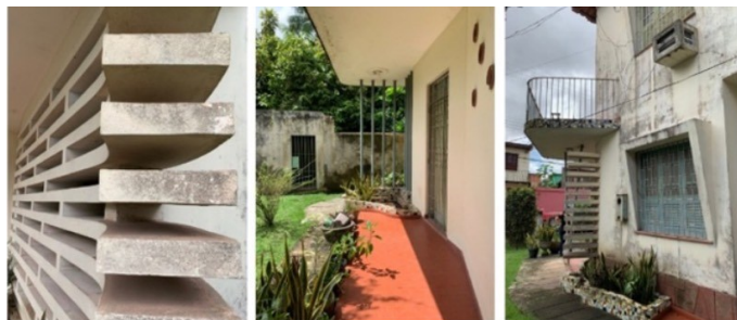
Figura 8 – Detalhes da fachada: painel em concreto, colunas metálicas e brises em plano inclinado. Fonte: Autoras, 2020
