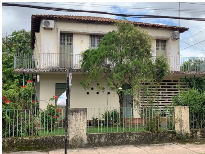
Figura 7 – Fachada da casa nº 1281, em Abaetetuba. Fonte: Autoras, 2020
