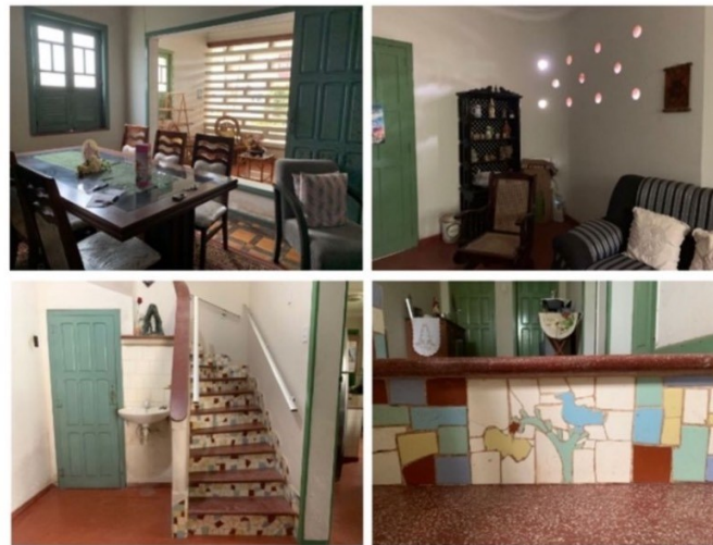
Figura 10 – Interligação entre ambientes, ventilação tubular típica da arquitetura moderna e detalhe da escada de acesso ao primeiro pavimento. Fonte: Autoras, 2020
