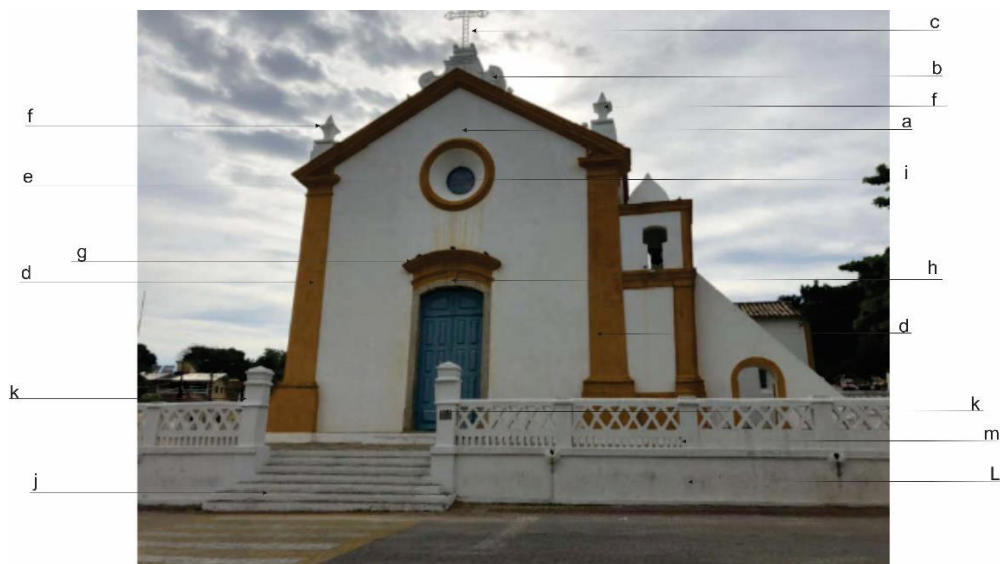
Figura 6 – Elevação frontal da igreja. Fonte: Os autores.
