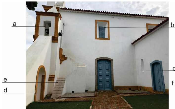
Figura 7 – Elevação lateral direita da igreja. Fonte: O autores.
