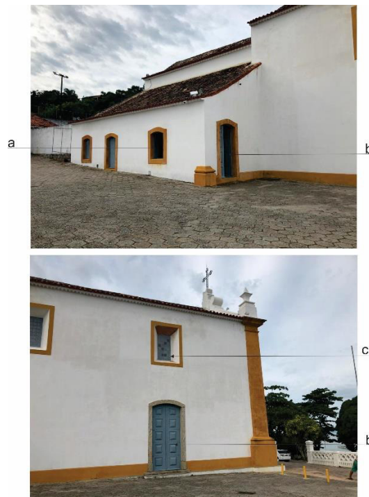
Figura 8 – Elevação lateral direita da igreja. Fonte: Os autores.
