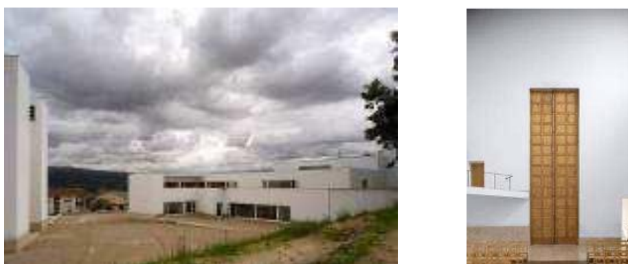
Figura 9. Vistas laterais e frontais da igreja e centro paroquial e vista interna da entrada da igreja. Fonte: Fernando Guerra /Casa da Arquitectura.
